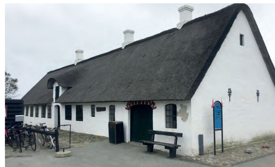
De traditionelle længehuse på Mandø er smalle og lange, stald og stue er under samme tag, de er udstyret med en lille og lav atengaf, enkle skorstene og simpel facadeudsmykning.
