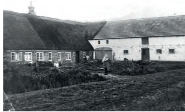
Mandø Byevej 24 var et eksempel på et traditionelt længehus (senere nedrevet, foto ca. starten af 1900-tallet), hvor der i slutningen af 1800-tallet blev tilføjet en trempellade direkte på den gamle længe. Muligvis er der bygget videre på dele fra en ældre staldbygning. Trempelladen fremstår med en høj hvidkalket facade, tag i naturskifer, et lille udhæng med synlige spærender, murede sålbænke enkelte steder og en gesims ved etageskiftet. Bygningen fremstår med revleluger, -døre og -porte samt smedejernsvinduer og 1800-tallets karakteristiske støbejernsvinduer (se side 50).
