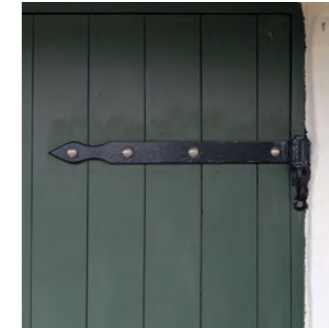
Eksempel på et stabelhængsel, som er typisk for revlsluger (samt -døre og -porte) på Mandø.
