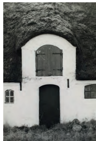
Mandø Byvej 15 (opført 1838, foto 1979) fremstår med simple buede vinduer med stabelhængsler fastgjort på karmen. Lugerne er muligvis mørkegrønne og stabelhængslerne er sorte.
