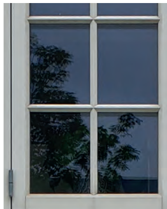
Eksempel på et plastikvindue med tolagsglas og termoruder. Sprosserne er udformet spinkelt og med en trekantsliste, hvilket bidrager med en lethed til vinduet. Dog har glasset en plan og mørk overflade, hvor omgivelserne og sprosserne spejles dobbelt på grund af de to lag glas. Både glasset og plastikoverfladen giver facaden et ensformigt udtryk sammenlignet med et kittet trævindue malet med linoliemaling.
