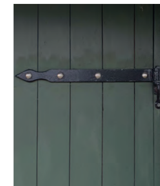
Eksempel på en revledør på Mandø, hvor stabelhængsel er indstukket i karmen. Stabelhængsler er en almindelig standardvare i byggemarkederne.
