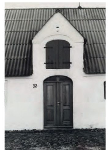
Mandø Byvej 32 (opført 1870, foto 1979) er et eksempel på et traditionelt længehus. Døren er en tofløjet fyldningsdør med to fyldninger og en overramme med to ruder. Døren er monteret på indersiden som ved de ældre traditionelle længehuse og er malet med ådringsteknik (se s. 49).
