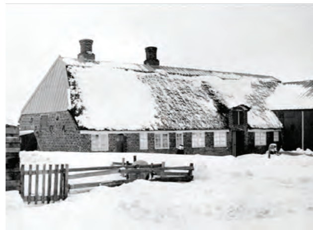
Mandø Kirkevej 4 (foto ca. starten af 1900-tallet) er endnu et eksempel på en trempelkonstruktion, som i dette tilfælde er bygget ovenpå resterne af en gammel lade. Trempelladen er en tilbygning til et traditionelt længehus og er særlig unik ved, at man har benyttet 1800-tallets industrielle pandeplader både til tag og til dele af facadebeklædningen. Dette er også en del af kultur- og udviklingshistorien på Mandø.
