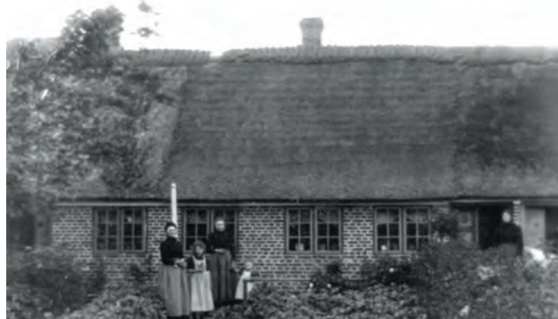
Eksempel på tofarvede vinduer med mørk karm og lodpost samt lysere ramme og sprosser (Mandø Byvej 21).
