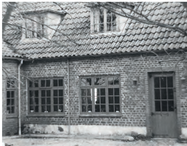
Mandø Byvej 26, Mandø Kro (opført 1900, foto 1979) er et eksempel med mange forskellige vinduer fra forskellige tider. Her ses vinduer fra starten af 1900-tallet med et til tre fag, overramme, sprosser og kitfals. Vinduerne er malede i en mørk nuance, udført med ruder i cylinderglas (se s. 42), tophængte overrammer og sålbænke i teglsten. Over vinduerne ses en tegloverligger. Døren er en form for revledør med et øvre parti af ruder og sprosser. Døren synes at have samme nuance som vinduerne, og døråbningen har en nyere muret indfatning.
