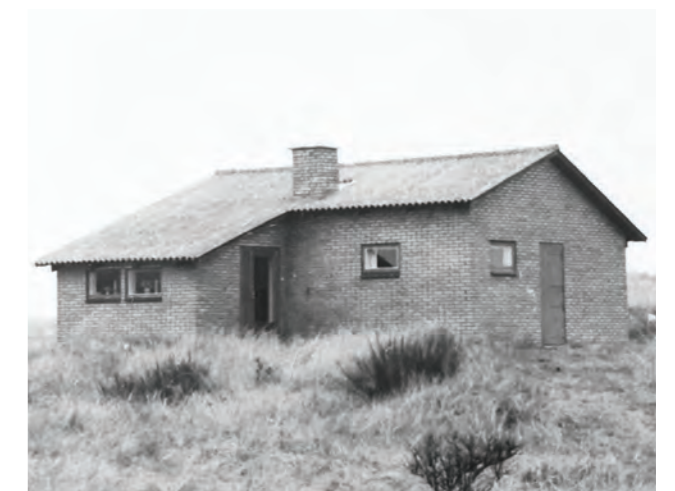
Vestervej 25 (opført 1961, foto 1979) er et godt eksempel på 1960'ernes parcelhus. Dette er et typehus, som ikke har rod i den traditionelle byggeskik. Huset er enkelt, praktisk. Det adskiller sig dog fra de traditionelle huse, da det er opført i gule maskintegl og har tag i bølgeeternit, en lav taghældning med stort udhæng, skorsten midt i tagfladen og nye typer af vinduer og døre.
