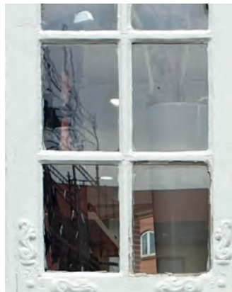
Eksempel på et kittet vindue med etlags-ruder i cylinderglas. Spejlingen af omgivelserne bølger let og giver et spil til overfladen. Når solen brydes af glasset, giver det et varieret lysindfald. Kittede vinduer og gamle glasruder bidrager med liv og variation til facaden.
