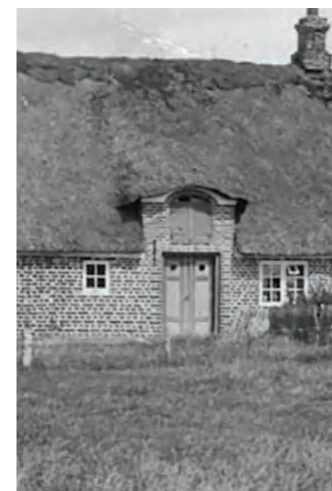
Mandø Byvej 24 (foto omkring 1900-tallet) fremstod med en repræsentativ, tofløjet dør med slagliste og fine runde glug foroven. Døren har været bemalet med to farver og enten været konstrueret som en enkel fyldningsdør eller en revledør med bemalede fyldningsdekorationer.
