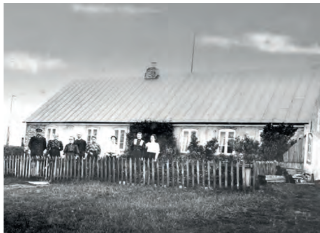
Vestervej 27 (opført 1877, foto ca. starten af 1900-tallet) er et af de ældste eksempler på et nyere længehus med blankt murværk, murede sålbænke, sadeldag og muret skorsten i kip. Huset er allerede på billedet delvist pudset op og kalket hvidt. Enten er huset opført med pandeplader som på billedet eller muligvis en anden tagtype (f.eks. naturskifer). Vinduerne er store, torammede trævinduer med tre ruder i hver ramme samt sprosser og kitfals. Vinduerne er malet hvide, men har muligvis tidligere været malet i en mørkere nuance. Gavlen fremstår med murankre. En særlig detalje er de murede indfatninger omkring vinduerne, som ikke ses andre steder på Mandø.
