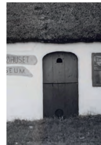
Mandø Byvej 5 (opført 1830, foto 1979) fremstod med en simpel tværdelt revledør med brede planker, rundbuet glug og et muret stik og gesims. Denne type revledør er typisk for stalldørene på Mandø. Over døren anes spor efter et mindre atengaf.
