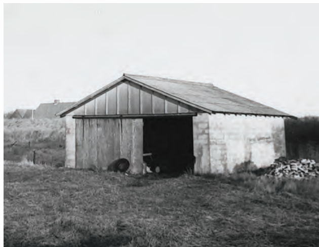
Maskinhuset på Mandø Byvej 9 (foto 1979) er et eksempel på en bygning opført i gasbeton/betonblokke og bølgeeternit, som typisk blev brugt til bygninger i 1960'erne. Gasbeton er et praktisk materiale, da det er diffusionsåbent og let at bygge med, men visuelt adskiller det sig fra de traditionelle materialer, da det ikke ældes på en smuk måde.
