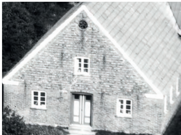
Østre Toftevej 2 (opført 1906, foto 1948) ses her fra syd. I gavlen er en tofløjet fyldningsdør med glasfyldning øverst. Fyldninger og slagliste er markeret med en lys farve, og rammer og karm i en mørk nuance. Døren er ikke monteret på indersiden som ved de ældre traditionelle længehus, men i en dørkarm placeret i døråbningen. Vinduerne er torammede med tre ruder og sålbænk. Øverst i gavlen ses et rundt dekorativt støbejernsvindue.
