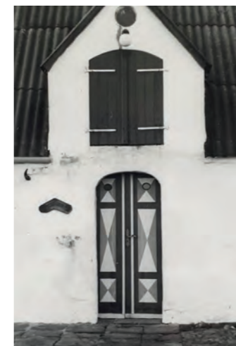
Mandø Byvej 34 (opført 1850, foto 1979) fremstår med en repræsentativ, tofløjet revledør med slagliste og fine runde glug foroven. Døren er dekorativt bemalet i tre forskellige farver, hvor slaglisten er markeret, og fyldningerne er malet på som dekoration.
