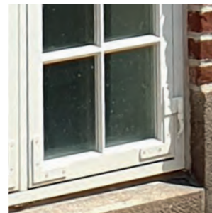
Eksempel på et kittet vindue med smalle sprosser og etlagsglas. Løsningen giver vinduet et let og spinkelt udtryk.
