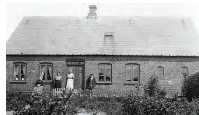
Vestervej 11 (opført 1900, foto omkring 1900-tallet) er et godt eksempel på et nyere længehus med blankt murværk, murede sålbænke, saddeltag i naturskifer, et lille udhæng, muret skorsten i kip og tagrender samt nedløb i zink. Vinduerne er store, torammede med tre ruder i hver ramme og sprosser med kitfals. Karm og lodpost er malet i en mørk nuance, og rammer og sprosser er malet i en lidt lysere nuance. Både i tagfladen og facaden til højre ses støbejernsvinduer, hvilket også er tidstypisk. Døren er en bred, tofløjet fyldningsdør med tre profilerede fyldninger og en overramme med fire ruder og sprosser med kitfals. Døren er malet i en mørk nuance.
