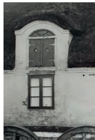
Bolongvej 2 (opført 1800, foto 1979) fremstod med revleluge med rudeformede glug og stabelhængsler fastgjort på karmen. Over revlelugen ses et tredelt kittet trævindue med buet form, som følger arkengaffets murede stik.
