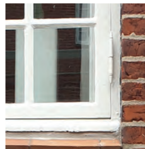
Eksempel på et kittet vindue og hamborghængsler malet med hvid linoliemaling. Materialerne og udformningen giver en lethed og et spil til facadens samlede udtryk.
