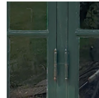
Eksempel på traditionelle hamborghængsler, som er placeret på lodposten, som det har været typisk for de kittede vinduer på Mandø. Det giver et roligt og enkelt udtryk, når vindue og hængsler er malet i samme farve. Denne smukke type hængsler kan fortsat købes.
