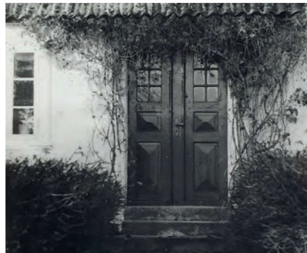
Vestervej 27 (opført 1877, foto 1979) har stadig den originale dør fra 1800-tallet. Den er et fint eksempel på en tofløjet fyldningsdør med ruder og sprosser i øverste ramme. Både fyldninger og dørgreb er detaljerede. Døren var oprindeligt malet i en ensfarvet mørk nuance.
