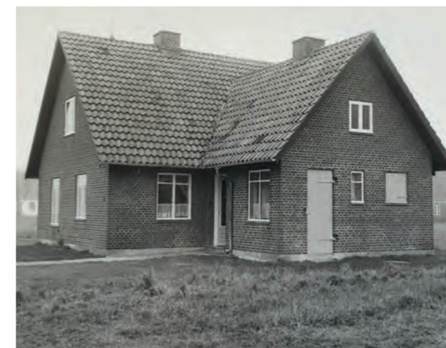
Mandø Byvej 13 (opført 1952, foto 1979) er et eksempel på en murstensvilla på Mandø. Ligesom de traditionelle huse på Mandø har denne bygning et stejlt saddeltag, blankt murværk i røde tegl, røde tagsten og skorsten i tagryggen. Det adskiller sig ved at have et markant udhæng, sternbrædder, synlige spærender samt nye typer af vinduer og døre.
