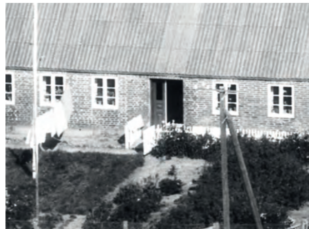
Mandø Byvej 23 (opført 1900, foto 1948) er et af de nyere eksempler på et traditionelt længehus. Huset fremstod med torammede vinduer med tre ruder i hver ramme. Døren var en tofløjet fyldningsdør med glasfyldning øverst, malet i en mørk nuance med slaglisten markeret med en lys farve. Døren var ikke monteret på indersiden som ved de ældre traditionelle længehus, men en dørkarm placeret i døråbningen.
