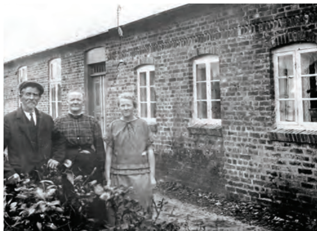
Mandø Byvej 26 (ombygget 1900, foto ca. starten af 1900-tallet) fremstod som et typisk eksempel på et nyere længehus med blankt murværk, et lille udhæng og murede sålbænke. Huset har ikke en synlig sokkel men fremstår med pigstensbelægning. Vinduerne til venstre sidder langt fremme i facaden, de har samme højde og muret stik som døren og er store dannebrogsvinduer med sprosse i nederste ramme. Vinduerne til højre sidder ikke lige så langt fremme i facaden, de er mindre, torammede vinduer med tre ruder i hver ramme. En unik detalje er den murede tandsnitsfrise (detalje øverst i facaden til højre), som ikke ses andre steder på Mandø. De forskellige variationer i facaden tyder på, at huset har gennemgået ændringer. Huset er muligvis opført i slutningen af 1800-tallet og efterfølgende bygget om. På et tidspunkt i 1900-tallet er huset igen bygget om med en anden type vinduer og døre, øget facadehøjde samt tegltag med halvvalm (se s. 36).
