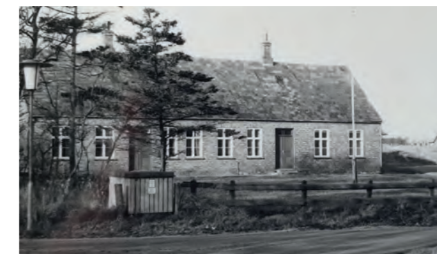
Vestervej 1, Mandø Skole (opført 1910, foto 1979) er et godt eksempel på et nyere længehus med blankt murværk, murede sålbænke, saddeltag i naturskifer, murede skorstene i kip og tagrender samt nedløb i zink. Vinduerne er store dannebrogsvinduer med sprosser og kitfals i de nederste rammer. Vinduerne er malet hvide, hvilket ofte ses ved bygninger fra starten af 1900-tallet. Et lille støbejernsvindue kan skimtes i tagfladen. Dørene er brede, tofløjede fyldningsdøre med tre profilerede fyldninger. De har begge vinduer over dørene bestående af tre ruder opdelt af to mindre lodposter og er malede i en mørk nuance.
