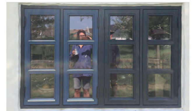
Eksempel på, hvordan maling af alulister og hængsler i samme farve som vinduerne kan skabe et mere ensartet og roligt udtryk. Til venstre ses den del af vinduet som endnu ikke er malet og til højre ses den del af vinduet som er blevet malet. Privat foto, Mandø Byvej 17.
