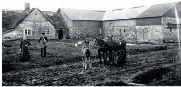
Billedet fra Midtvej 6 (foto ca. starten af 1900-tallet) fortæller om en tydelig udviklingshistorie, hvor der er blevet bygget til efter behov. Trempelladen er sandsynligvis startet som en tilbygning i traditionel byggeskik. I slutningen af 1800-tallet har man forhøjet staldlåde med en trempelkonstruktion, hvor man har anvendt bræddebeklædning i trempelstykket over murstenene. Trempelladen fremstår med store revleporte, enkelte støbejernsvinduer og et naturskifertag med et forholdsvist stort udhæng. På tagfladen ses tre lave tagryttere.
