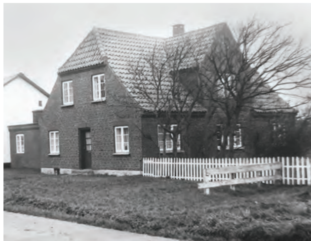
Mandø Byvej 24 (opført 1939, foto 1979) er et godt eksempel på en muremestervilla. Huset er velproportioneret med en centreret gavlkvist, taget er halvvalmet, opskalket og tækket med tegl. Tagfladen brydes kun af en muret skorsten, og facaden fremstår i blankt murværk. Vinduerne er malet hvide, og døren er malet i en mørk nuance. Der er anvendt en vinduestype med tre ruder i hver ramme, sprosser og kitfals, som også kan ses ved både de traditionelle og nyere længehuse. På dette hus anvendes den traditionelle ramme både i to, tre og fire fag.
